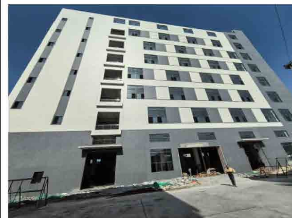
东南面：昌仁自动化设备有限公司
