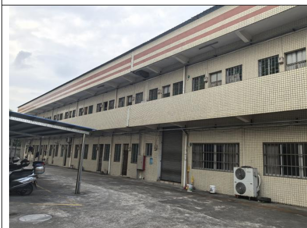
项目北侧-空置宿舍楼
