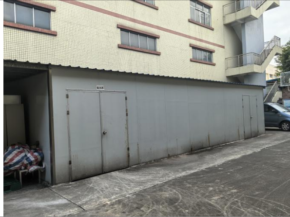
零散废水暂存间
