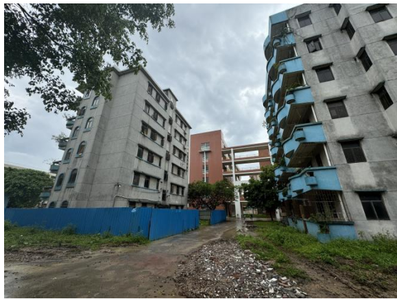
项目现状（宿舍楼、教学楼）
